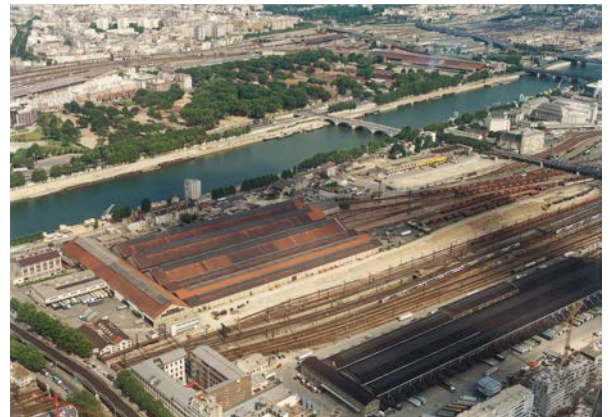
BnF, vue aérienne sur le site de Tolbiac, 1989 (droits non identifiés, document donné par la mairie de Paris pour le concours )
