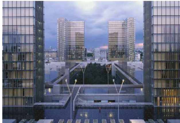
Vue de la BnF vers l'ouest, 1995 © Georges Fessy / Dominique Perrault Architecte / ADAGP, Paris 2018
