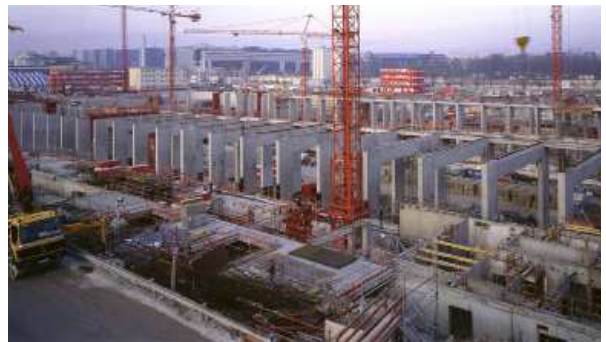
BnF, chantier : les portiques béton des salles de lecture recherche Nord-Sud, décembre 1992 © Michel Denancé / Dominique Perrault Architecte / ADAGP, Paris 2018
