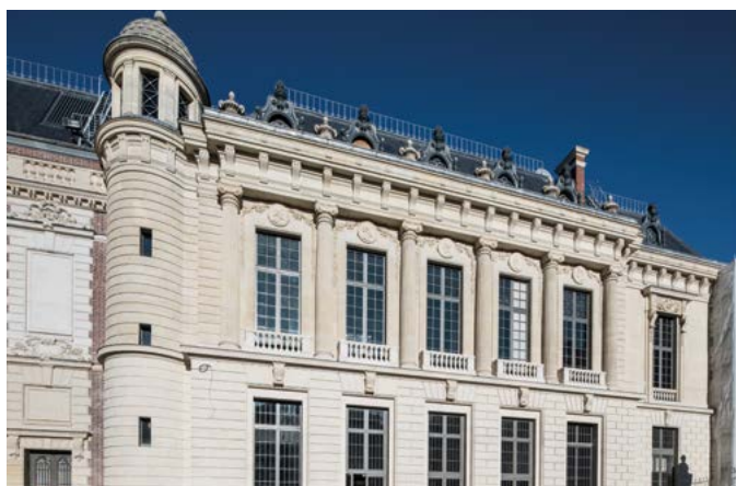
Façade de la BnF | Richelieu, côté rue Vivienne © Jean-Christophe Ballot / BnF / Oppic
